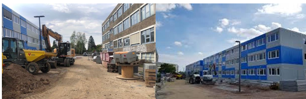
Abbildung 3: Erweiterung des Schulgebäudes um Containerbauten zum Schuljahresstart 2022/2023 (Foto: Universitätsschule Dresden)
