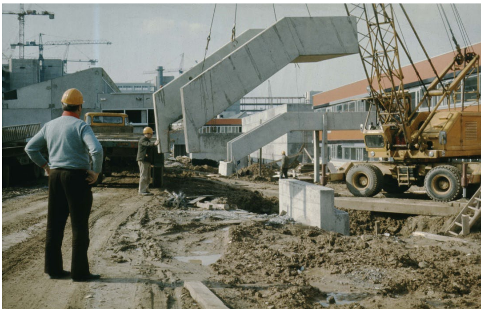
Abbildung 3: Die Laborschule während der Bauphase (Foto: unbekannt; Quelle: Universitätsarchiv Bielefeld, SPM-I 0614)
