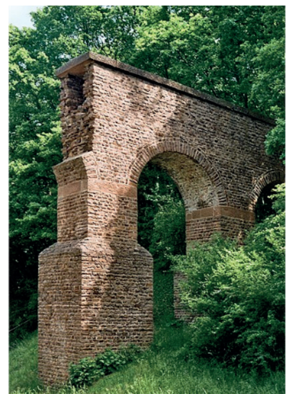
Abb. 1: Teilrekonstruiertes Aquädukt, Mechernich-Vussum (Foto von Mediatus 2010; https://commons.wikimedia.org/wiki/File:Mechernich-Vussum_Aquäduktbrücke.jpg (Zugriff: 09.08.2021).
